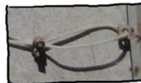
FIG. 3-D Cable loop
